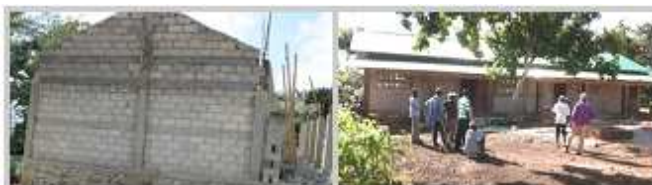
Avancement de la construction de 3 nouvelles salles de classe Photos Père Murat DORCENT septembre 2015
